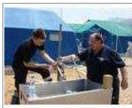
Reparatur der Wasserversorgung in der Zeltstadt Foto: Malteser
