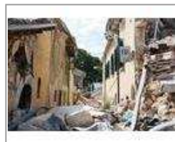
Eine Straße in Onna, dem Ort, in dem nur ein Haus nicht zerstört wurde. Foto: Malteser
